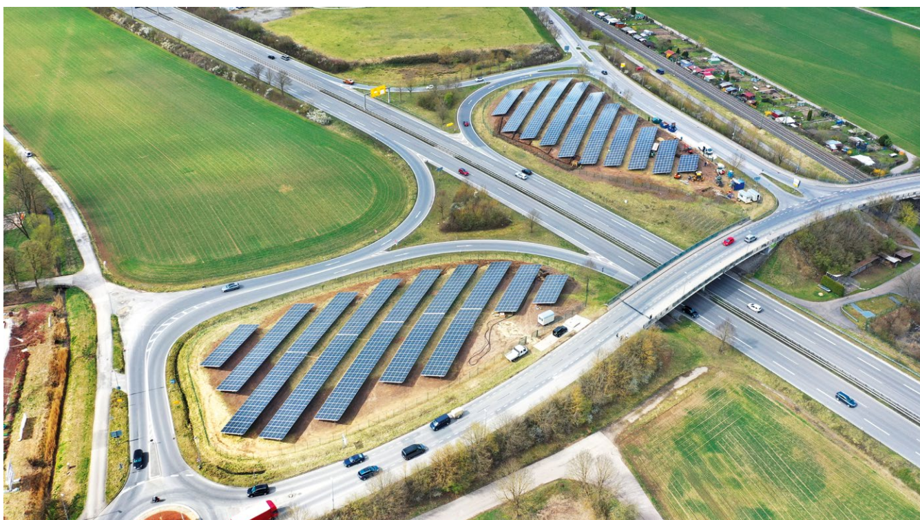
Solarpark Lustnauer Ohren (Quelle: Stadtwerke Tübingen/Grohe)
