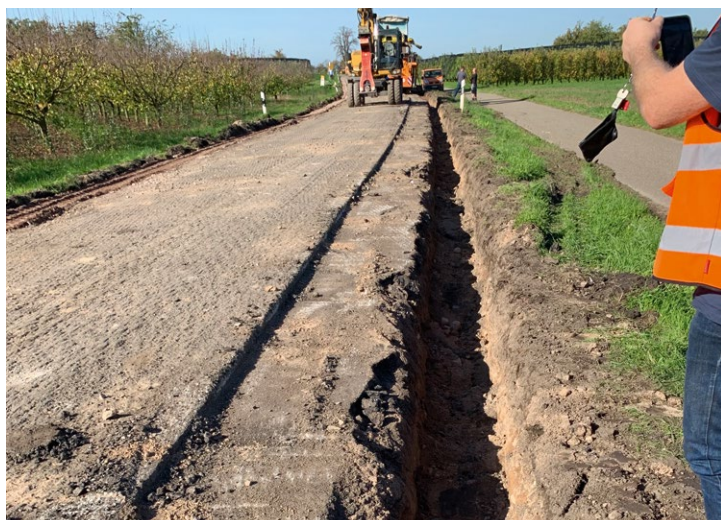
Abbildung 6: Erneuerung der Frostschutzschicht (Quelle: Regierungspräsidium Freiburg)
