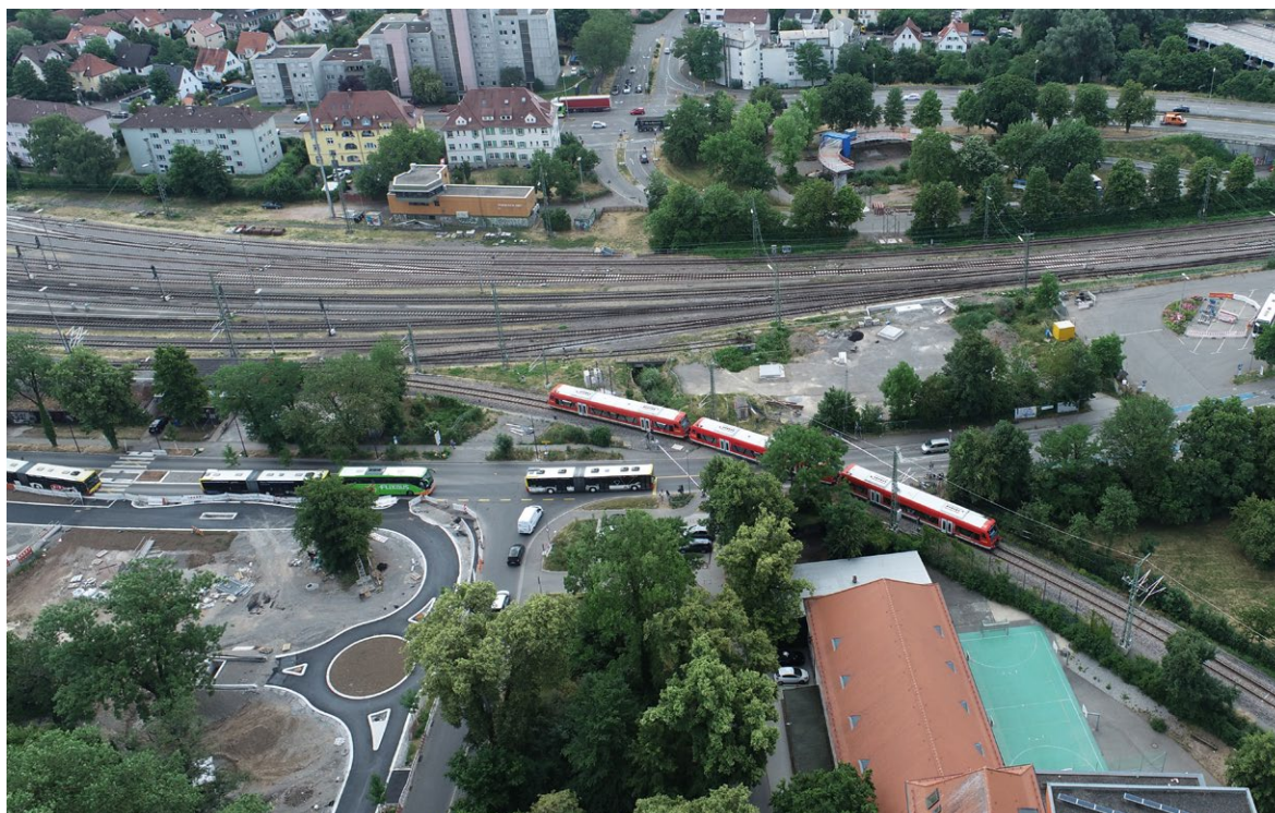
Bau der Radbrücke West mit Radkreisverkehr (Quelle: Universitätsstadt Tübingen)
