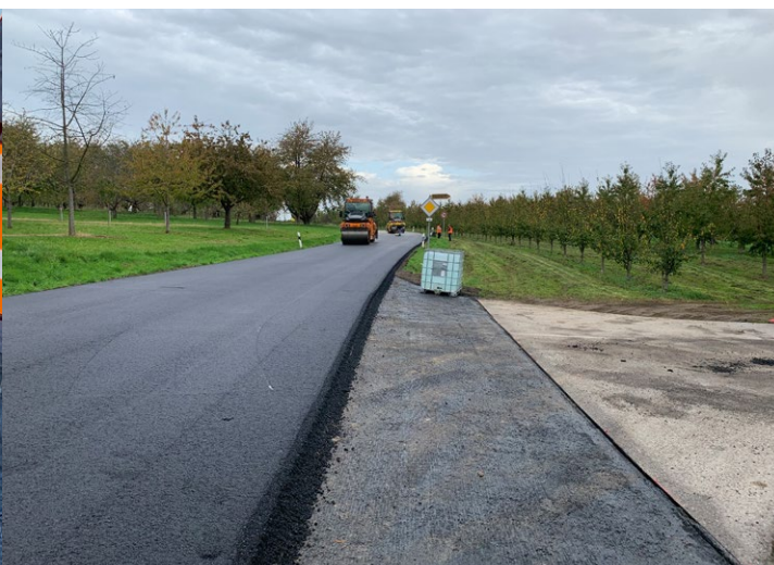
Abbildung 7: Einbau der Asphaltbinderschicht (Quelle: Regierungspräsidium Freiburg)
