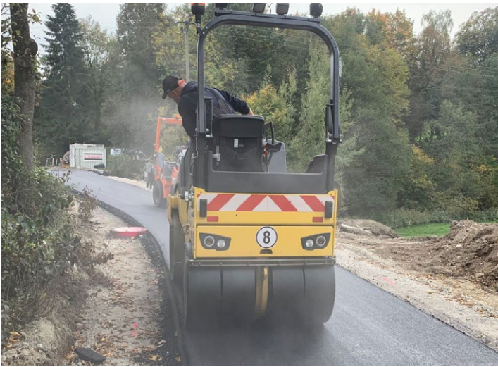
Abbildung 8: Radwegebau an der L 331 bei Wildpoltzweiler (Quelle: Ministerium für Verkehr Baden-Württemberg)
