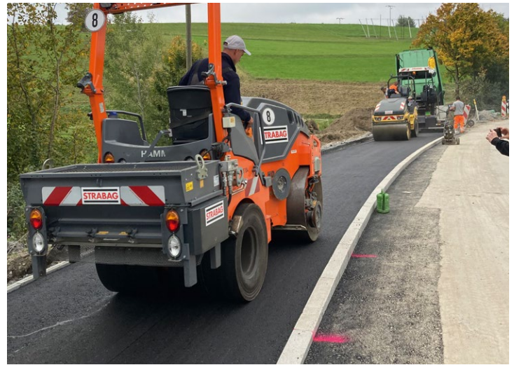
Abbildung 9: Versuchsstrecke Einbau des Asphaltmischgutes in den Radweg (Quelle: Firma Strabag)
