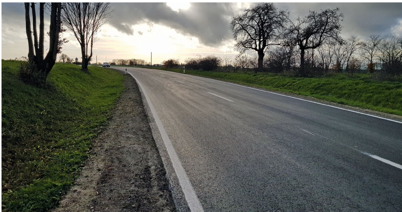
Abbildung 1: fertiggestellte Asphaltdeckschicht (Quelle: Ministerium für Verkehr Baden-Württemberg)
