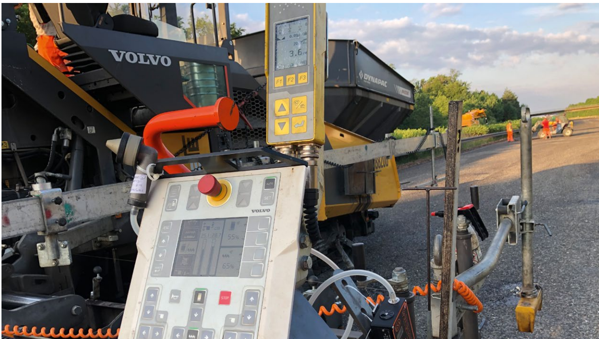
Abbildung 3: Luftprobe Bohle rechts am Fertiger (Quelle: BG BAU - Berufsgenossenschaft der Bauwirtschaft)
