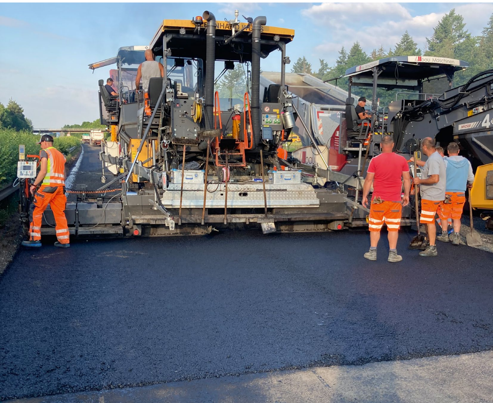
Abbildung 1: Einbau temperaturabgesenkter Asphalt (Quelle: Autobahn GmbH Niederlassung Südwest)
