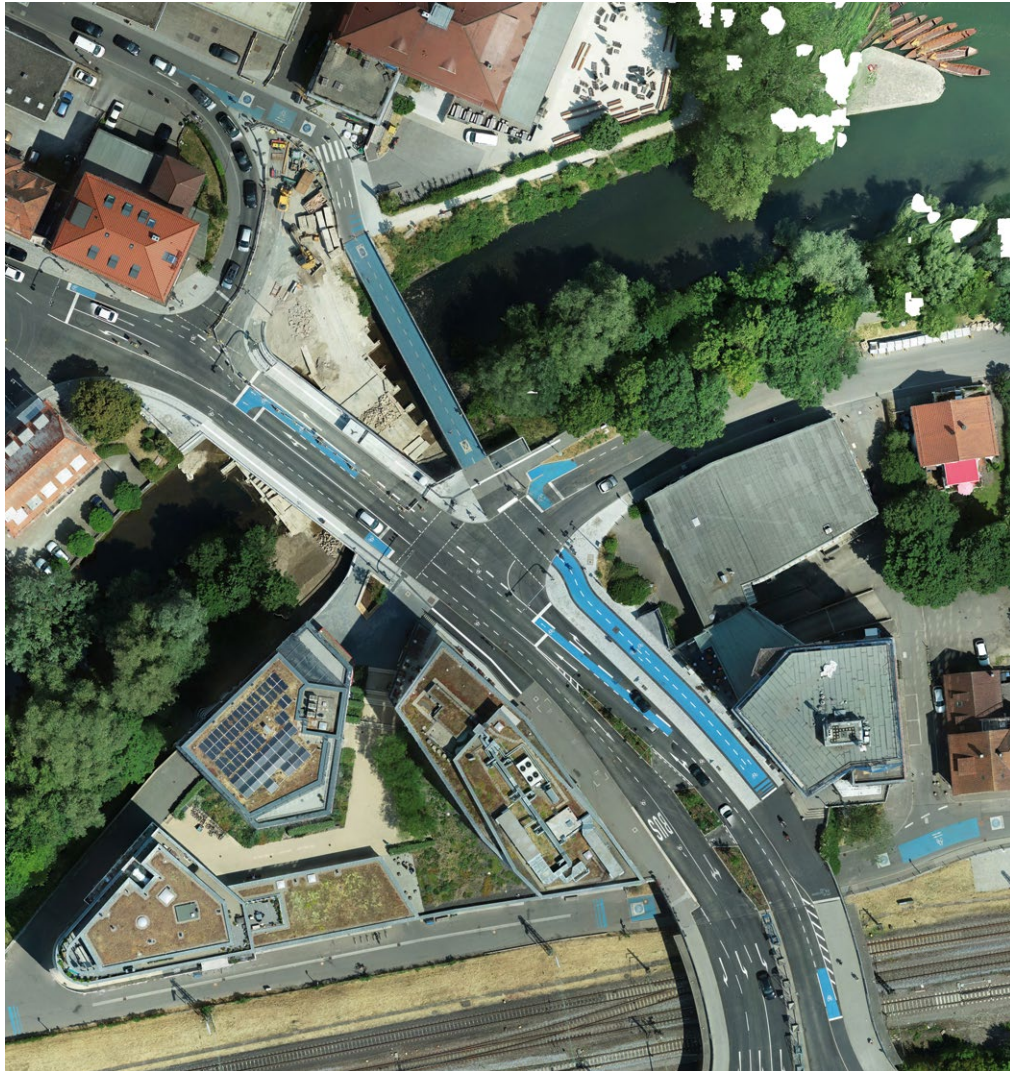
Radbrücke Mitte über die Steinlach (Quelle: Universitätsstadt Tübingen)
