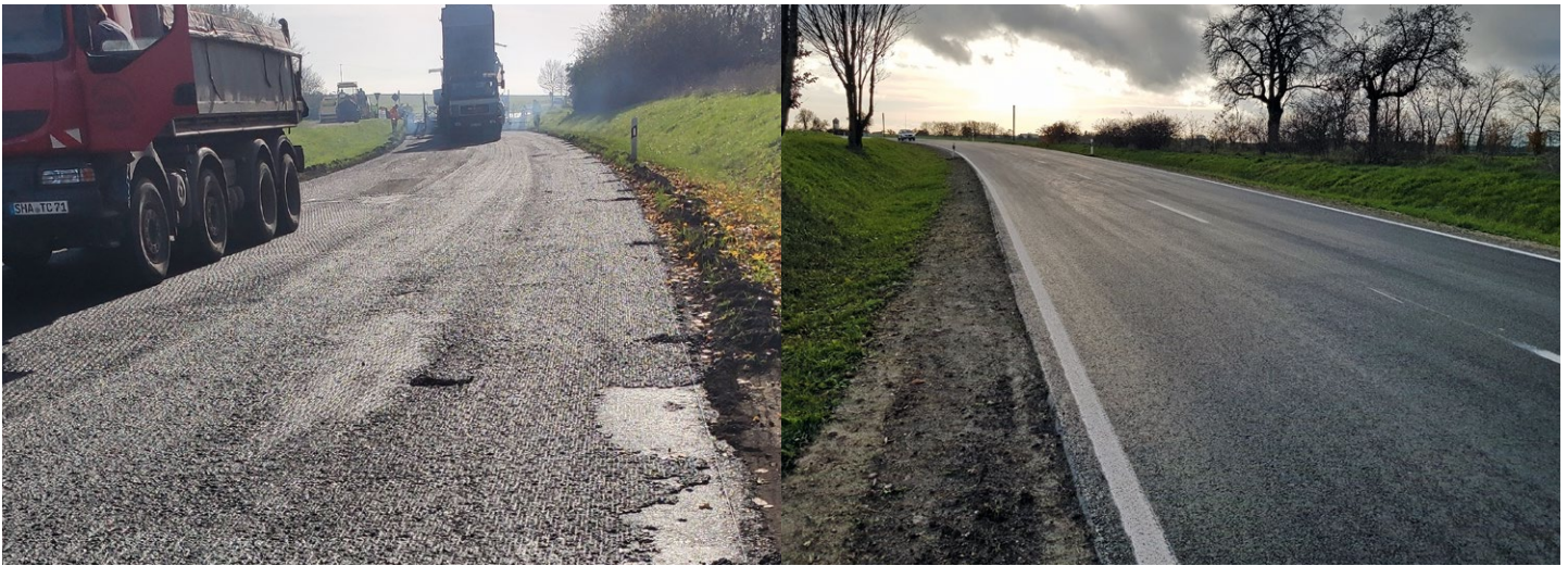
Abbildung 4: L1033 bei Gerabronn, gefräste Fläche und fertiggestellte Asphalttragdeckschicht (Quelle Ministerium für Verkehr Baden-Württemberg)
