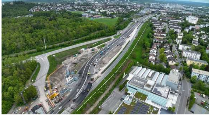
Blick Richtung Singen bauzeitl. Umfahrung zur Erstellung der Einhausung bei Sindelfingen-Goldberg
