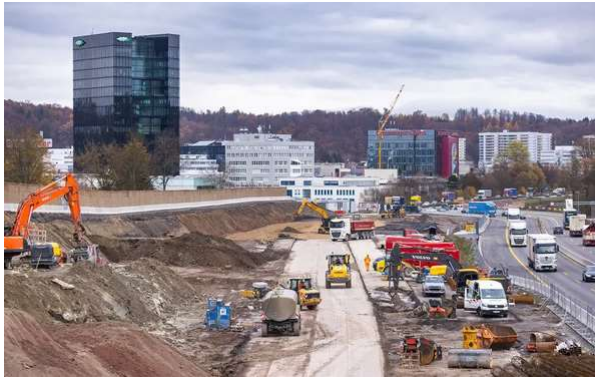
Bilder der DEGES-Internetseite, Blick Richtung Stuttgart
