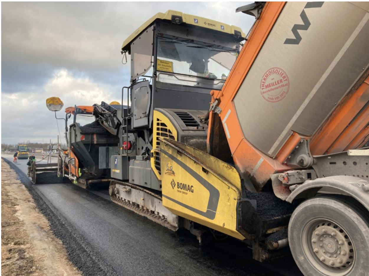
Abbildung 4: QAA 4.0: Unterbrechungsfreier Einbau dank optimierter Prozesse (Quelle: Autobahn GmbH Niederlassung Südwest)
