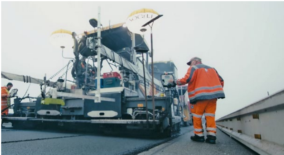
Abbildung 2: Niedrigtemperaturasphalt: mehr Gesundheitsschutz und Energieeffizienz (Quelle: Autobahn GmbH Niederlassung Südwest)
